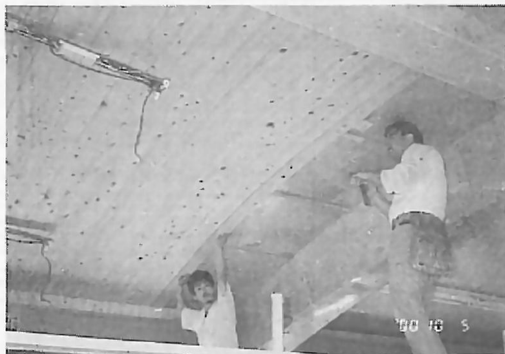
天井・板張り工事 2000年9月～11月
